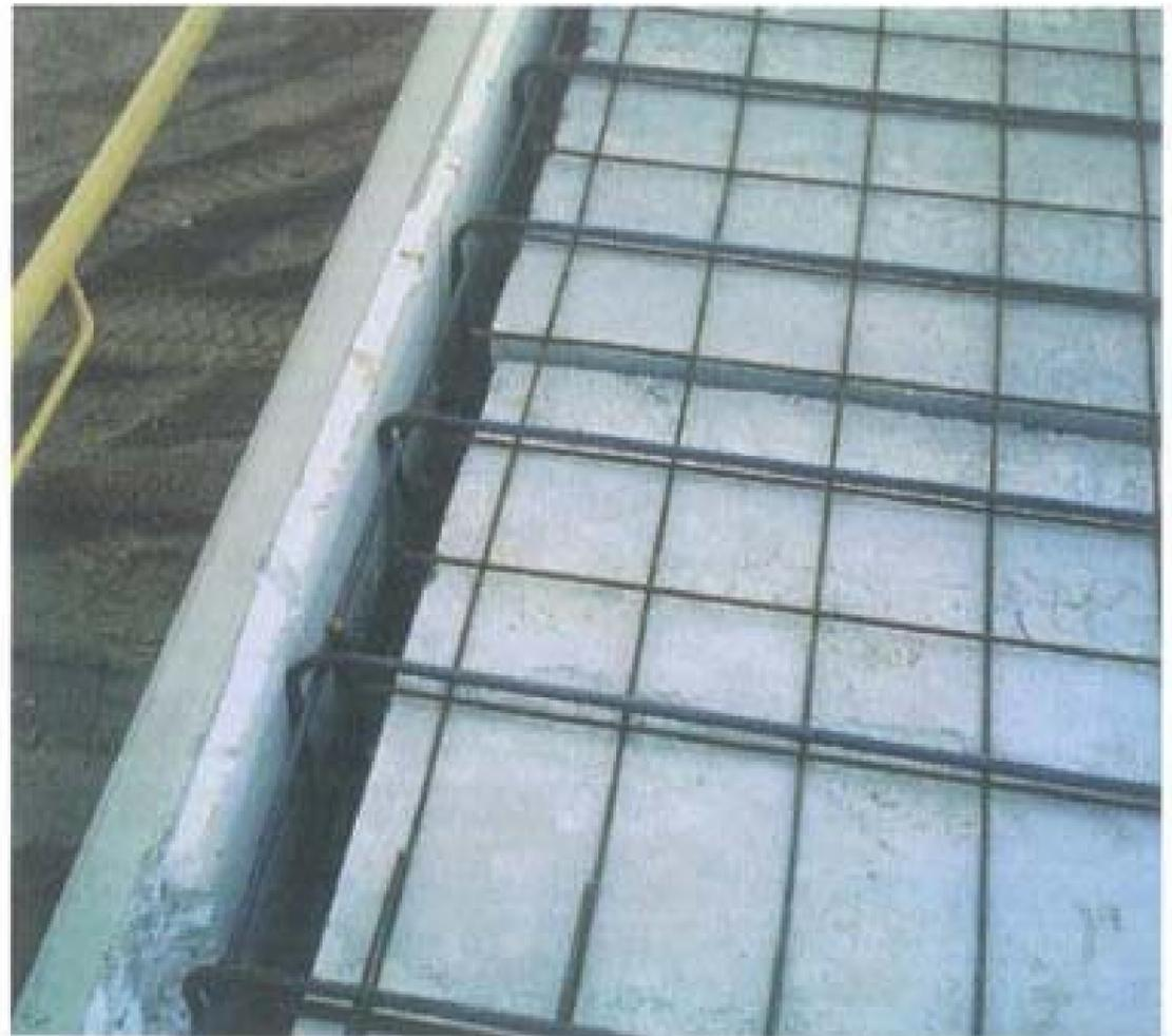
Dicho sistema utiliza paneles portantes prefabricados, formando celdas rígidas en dos direcciones ortogonales, en las que los paneles se unen entre sí mediante elementos metálicos, embebidos en los mismos, por soldadura. Se consigue de esta manera una estructura espacial, unida en todas sus caras, capaz de recibir los esfuerzos provenientes de las cargas gravitatorias y horizontales, ya que los paneles portantes actúan como pantallas rígidas.
